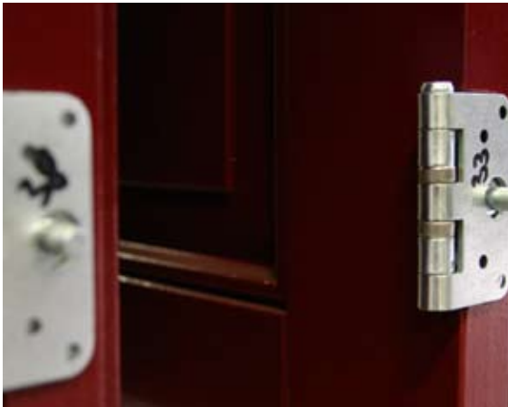
Elke deur heeft zijn eigen nummer, want niet één deur heeft exact dezelfde maten.
